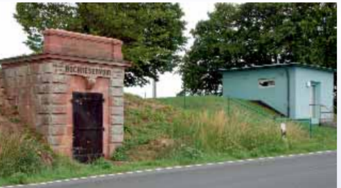
Alter Wasserhochbehälter an der Esselbacher Straße, daneben der neue Hochbehälter
